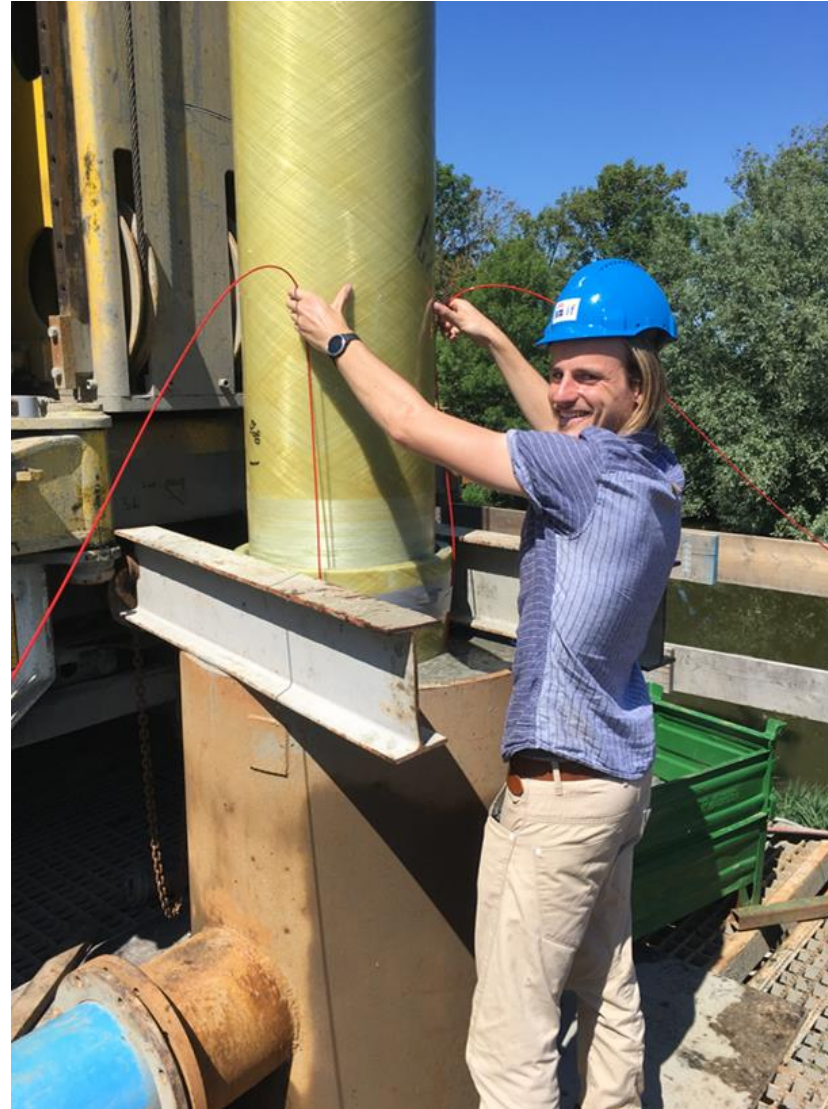
Composiet put, met glasvezel DTS kabel
