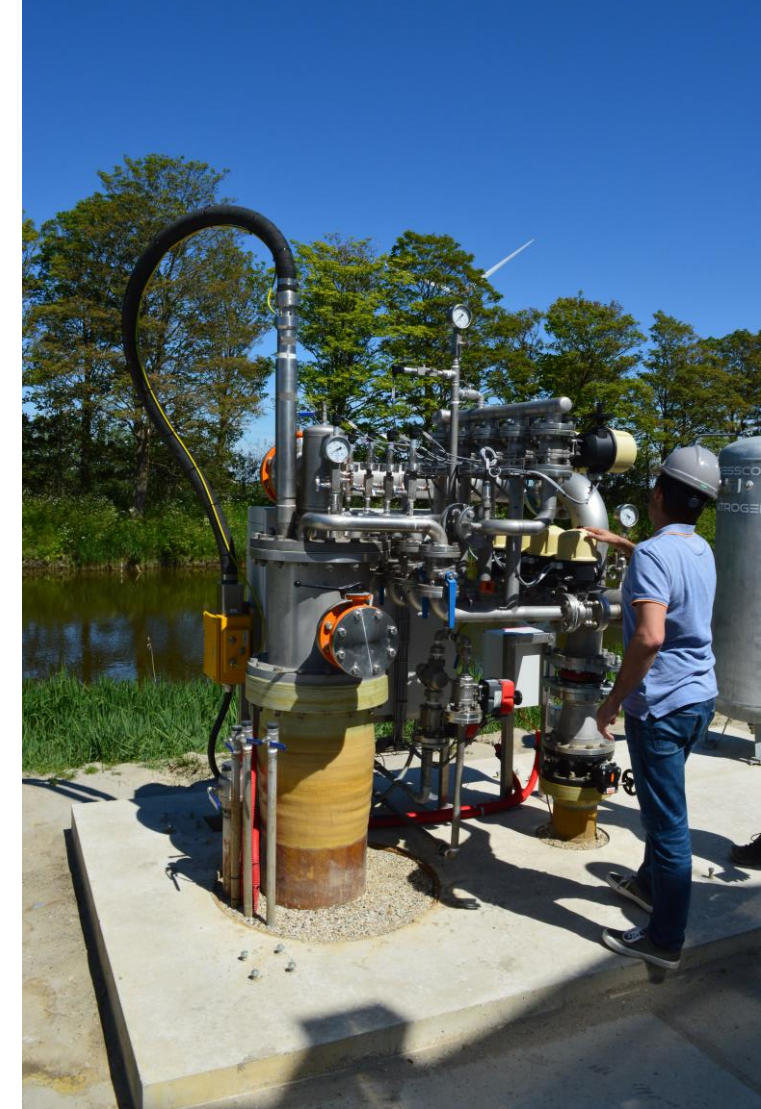
HT-bron met peilbuizen
