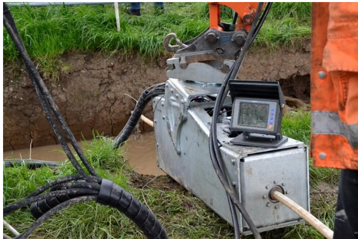
Figuur 2: Compacte installatie voor boring huisaansluitingen
