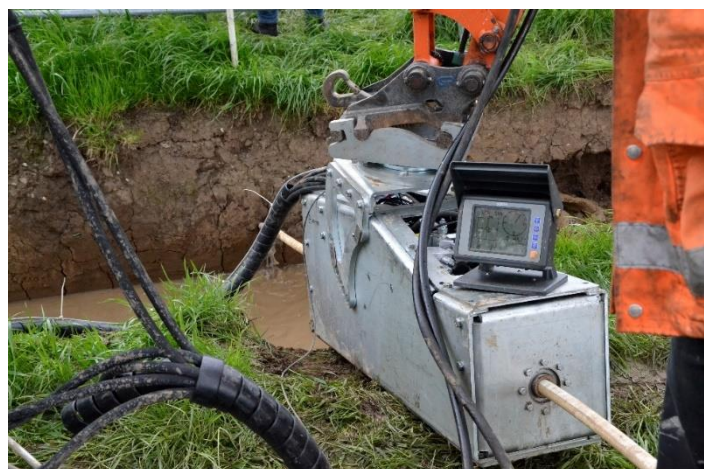
Figuur 2: Compacte installatie voor boring huisaansluitingen
