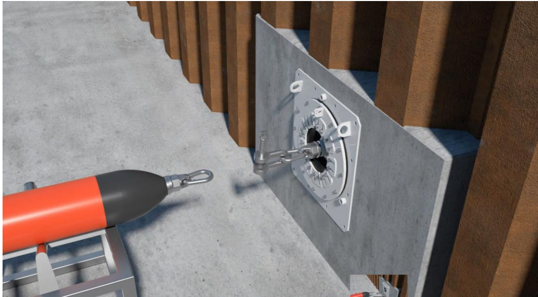
Figuur 7 Intrekken leiding
